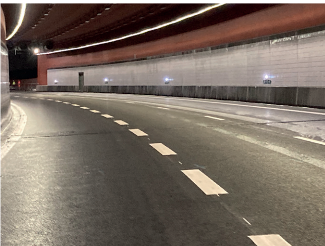
Mariefholmstunnel Göteborg Schweden
