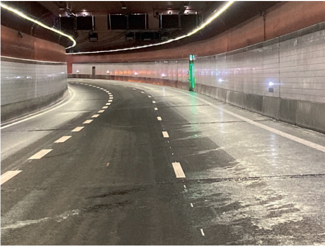
Mariefholmstunnel Göteborg Schweden
